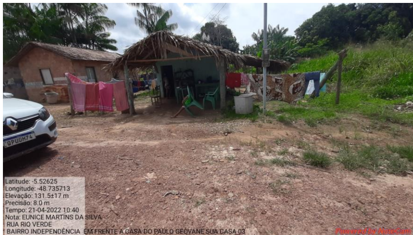
Figura 52 – Casas em área de risco
