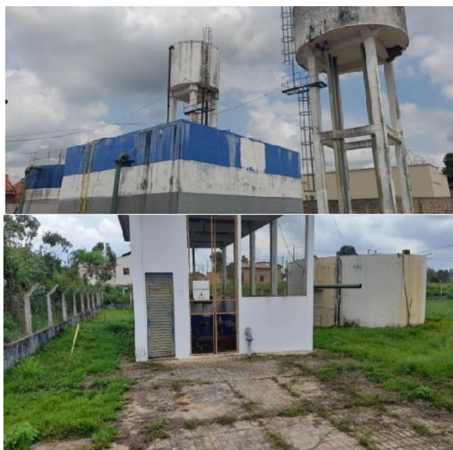
Figura 16 – RAP 1 ,2 e 3, REL 1 e 2 no Centro de Distribuição localizado na Vila Bragantino.
